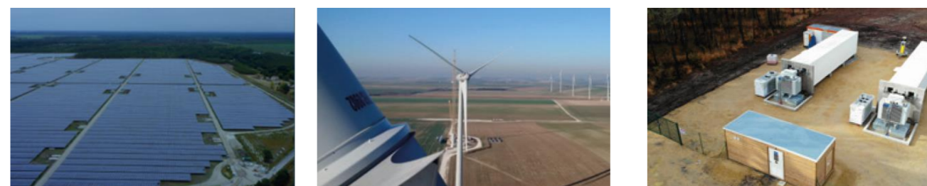
Figure 4 : De gauche à droite : Centrale Solaire de Cestas (300 MWc), Centrale Eolienne de Bussy-Létrée (26 MW), et Azur Stockage (6 MW, 6MWh) (source : NEOEN, 2019)
